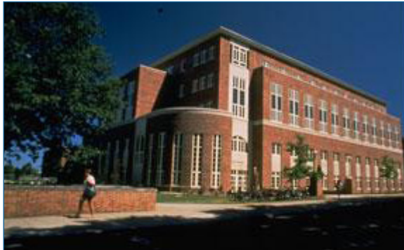
El edificio Joab Thomas de estadísticas en el campus de Penn State University Park.
